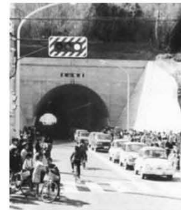
東山トンネル開通
