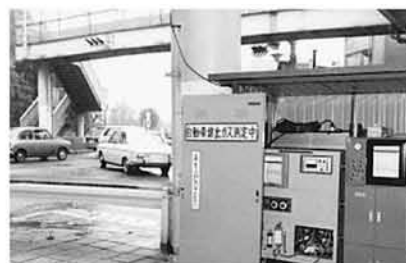
排気ガス測定装置が設置される
