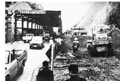
通7丁目切り通しの拡幅工事
