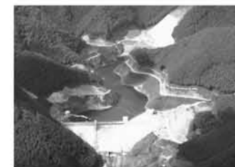
松田川ダムが完成
