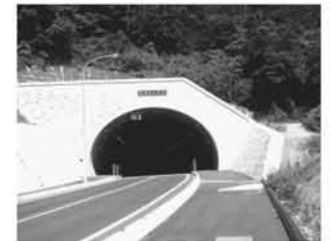
越床トンネルが開通
