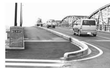
新しい葉鹿橋が開通
